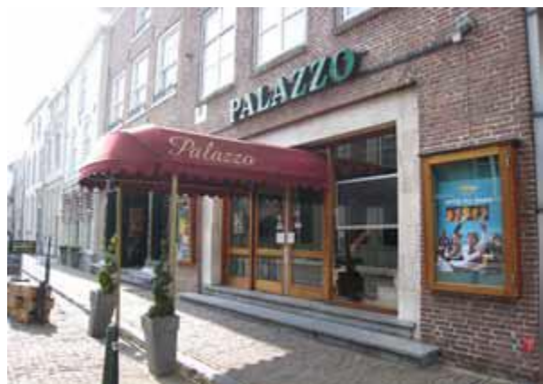
Luifel doorbreekt het straatbeeld. proportionering luifel past niet bij proportionering gevel.
