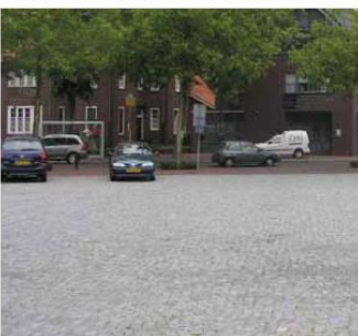
Kleine natuursteenkeien zijn minder besmettelijk en geven plein meer gebruikswaarde
